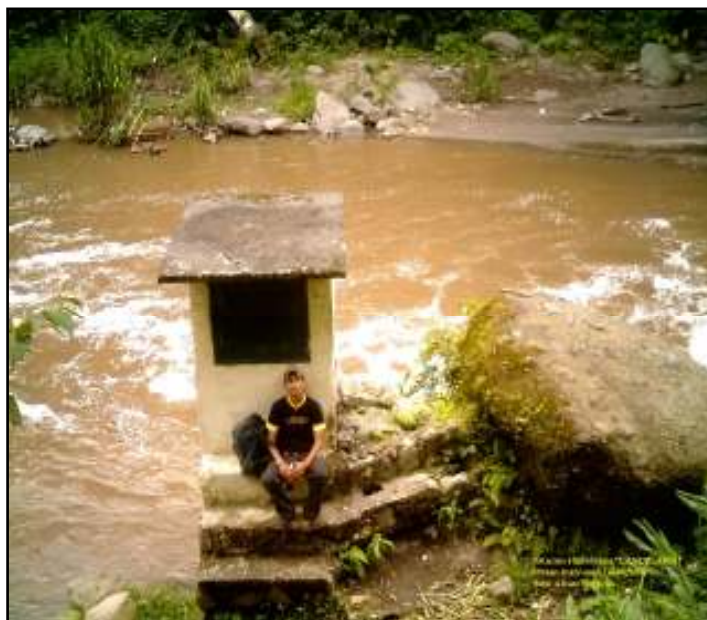
ESTACION HIDROLOGICA CANDELARIA
